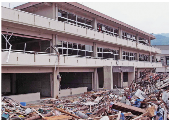
津波により被害を受けた校舎
